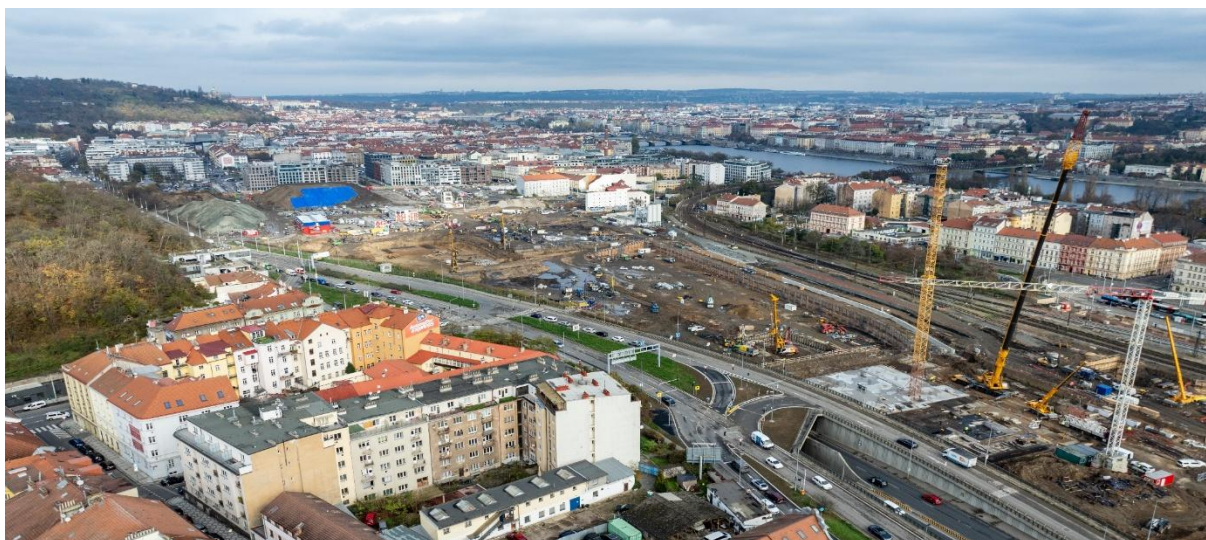
Obr. 1 Celkový pohled na stavenišť.
