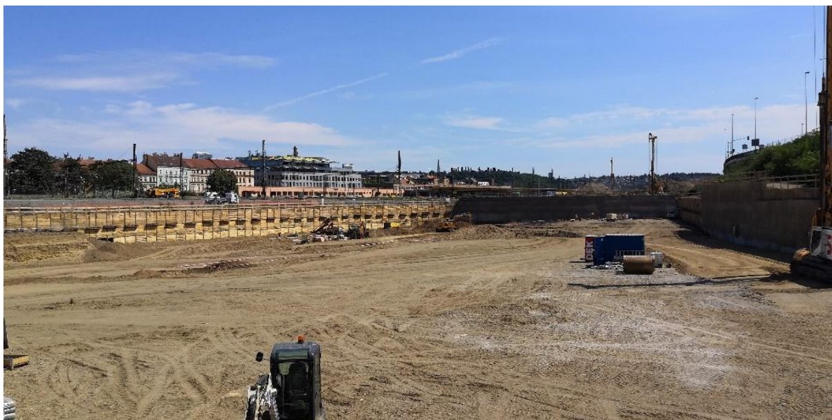
Obr. 3 Celkový pohled na staveniště před zahájením vrtných prací Fig. 3 General view of the construction site before drilling works began
