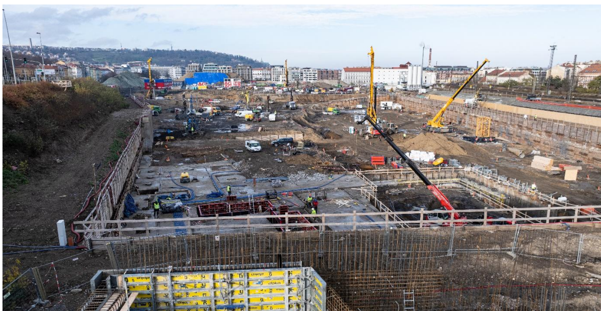
Obr. 4 Celkový pohled na staveniště v průběhu prací Fig. 4 General view of the construction site during the works
